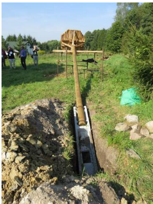
Рисунок 9. Конструкция (бетонное основание, деревянный столб и платформа для гнезда) изготовлены заранее. Также заранее вырыта яма для установки столба.
