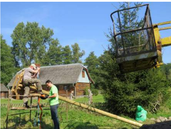
Рисунок 16. Платформу удобно поднимать с помощью крана или трактора.
