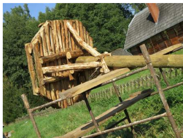
Рисунок 11. Деревянные детали платформы прочно соединены крупными гвоздями.
