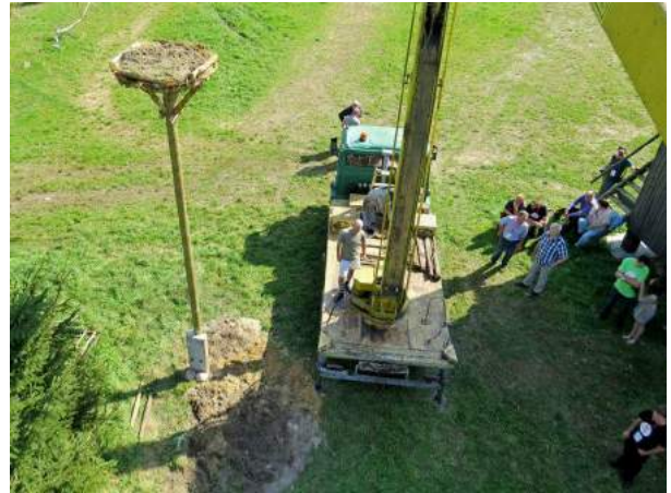
Рисунок 27. Процесс установки платформы завершен.
